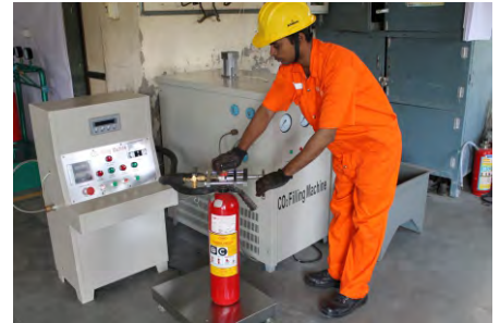
Co2 Extinguisher Refilling
